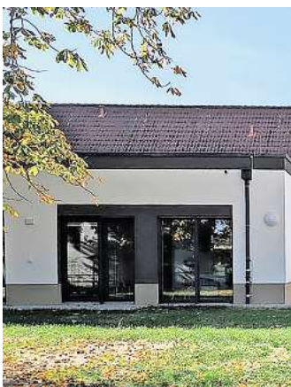
Die Kindertagesstätte „Gans schön fit“ in Nerchau wurde umfassend saniert. Foto: Kerstin Tronicke
