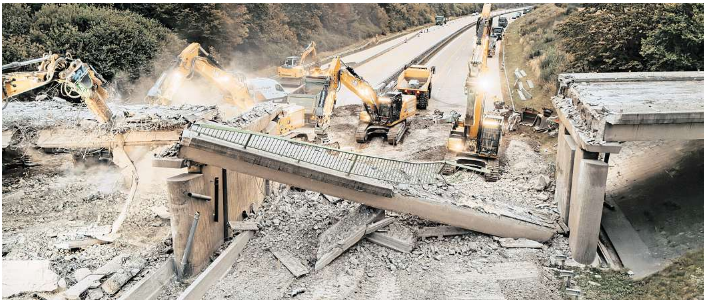
Rund um die Uhr waren die Bauarbeiter am Start und vorfristig fertig: Der Abriss der Brücke über die A14 bei Grimma war am Sonntagabend abgeschlossen.
