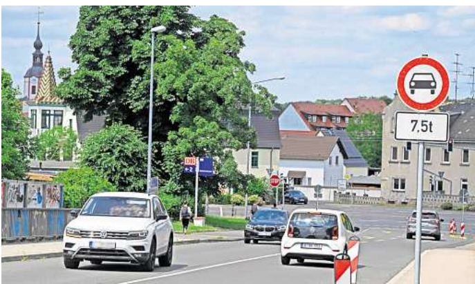
Die Brücke über die Bahngleise in Machern ist für Fahrzeuge über 7,5 Tonnen Gewicht gesperrt. Nun soll zunächst eine zweispurige Behelfsbrücke errichtet werden. Foto: Thomas Kube
