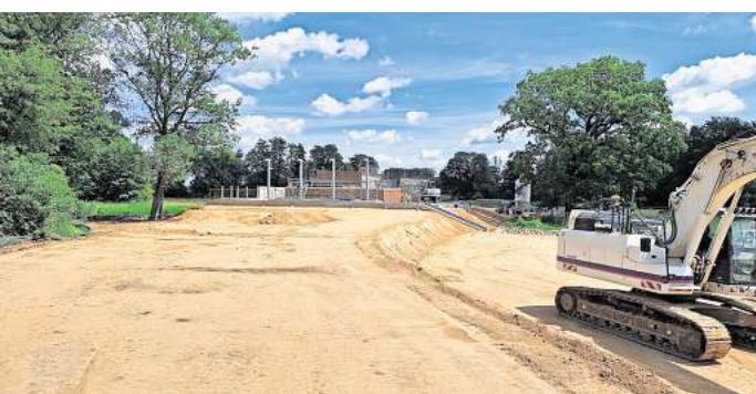
Baustelle am neuen Hochwasserschutzdeich in Püchau: Im Hintergrund entsteht in den kommenden Monaten das Schöpfwerk. Foto: Thomas Zechendorf / Landestalsperrenverwaltung Sachsen
