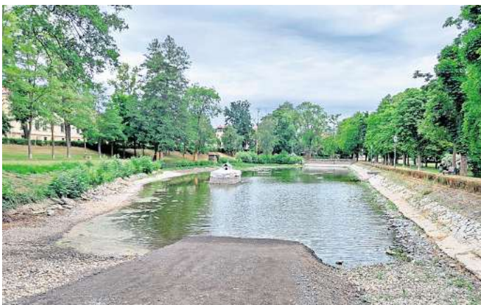
So sieht die Sanierung des Schwanenteichs aktuell aus. Foto: Elisabeth Hempe
