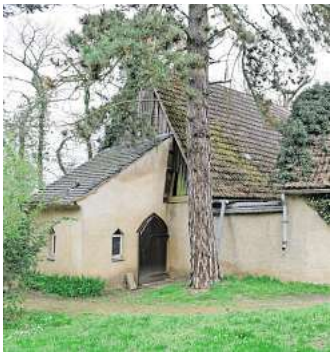
So sah die Scheune in Nerschau vor dem Umbau aus.
