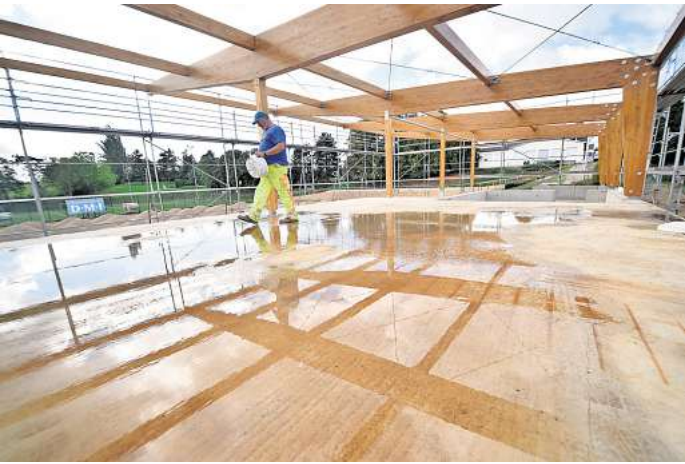
Die neue Tribüne in der Schuricht-Sportstätte in Leisnig steht. Die Balken fürs Dach des Tribünengebäudes sind montiert. Foto: Sven Bartsch
