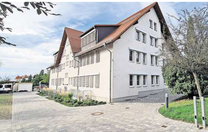
Die Regenbogenschule des Landkreises an der Nordstraße in Döbeln steht auf städtischem Grundstück. Der Landkreis kann dieses jetzt kaufen. Foto: Sven Bartsch
