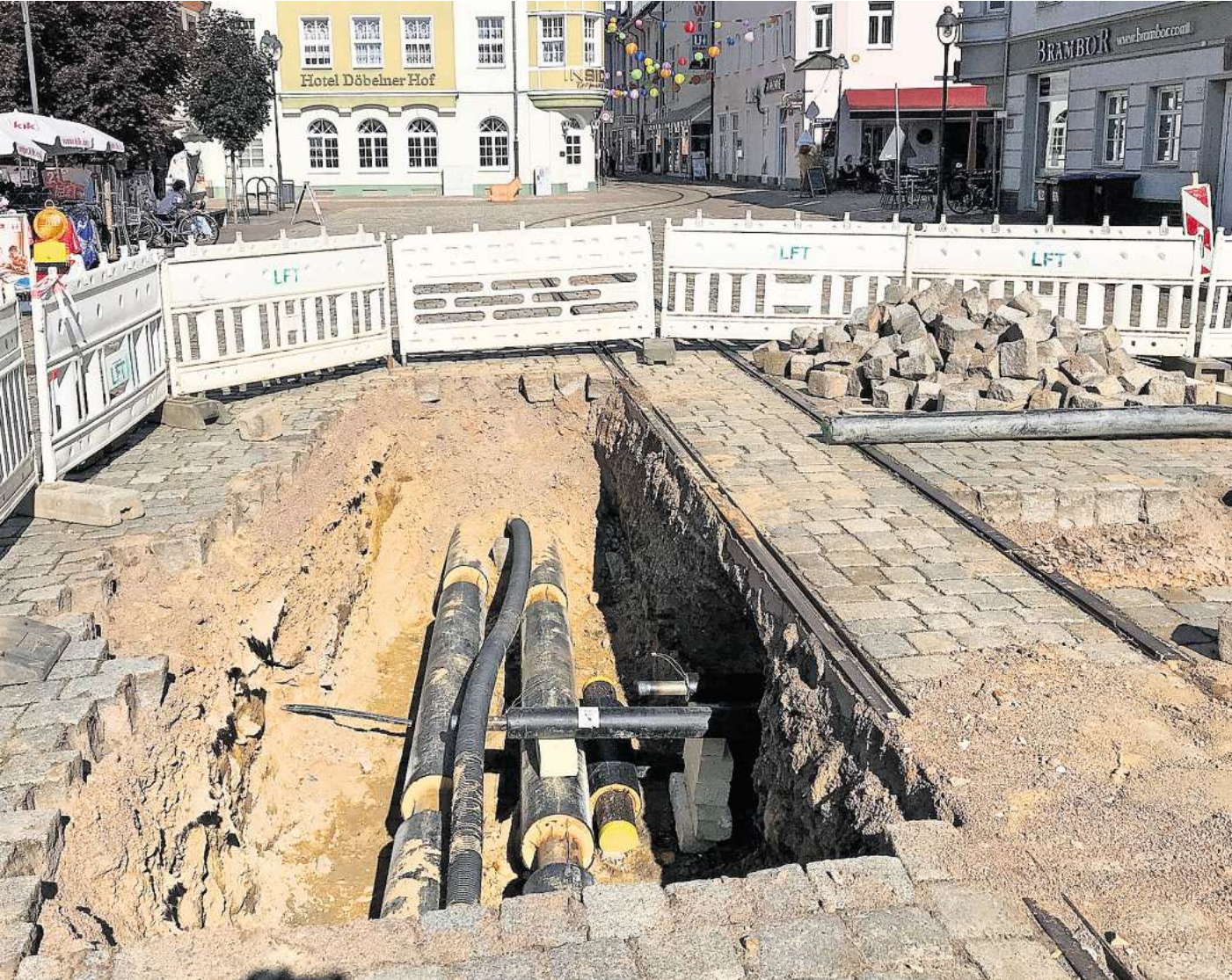
An mehreren Stellen in der Innenstadt lassen die Stadtwerke Döbeln derzeit buddeln, wie hier auf dem Niedermarkt. Foto: Olaf Büchel
