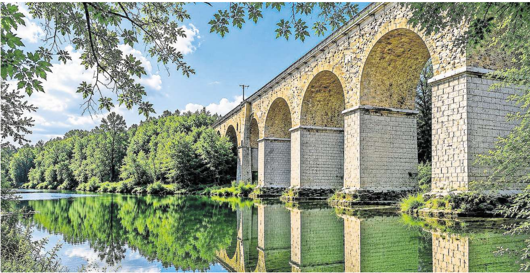
Majestätisch erhebt sich das Limmritzer Viadukt über dem Zschopautal. Das zwischen 1847 und 1852 errichtete Bauwerk gilt als längstes der sechs Viadukte der historischen Bankrottmeile und als Wahrzeichen sächsischer Eisenbahngeschichte. Foto: Elke Walter-Koch
