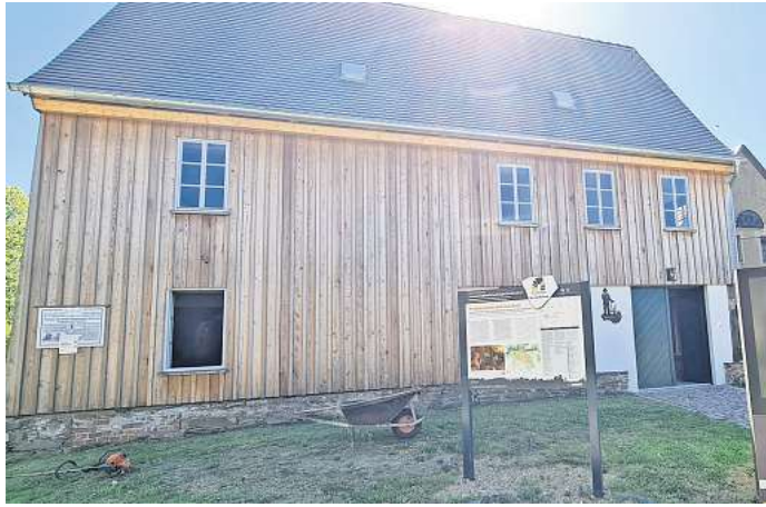
Das Gersdorfer Huthaus des Vereins Segen Gottes ErbStolln ist fertig saniert. Foto: Sven Bartsch
