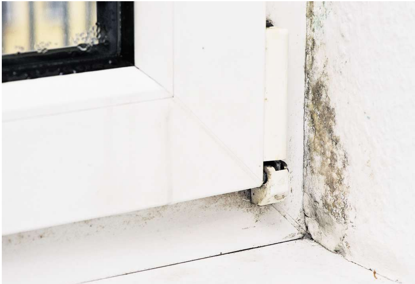
MIT 70-PROZENTIGEM ETHYLALKOHOL soll sich kleinflächiger Schimmelpilz in der Wohnung beseitigen lassen.
