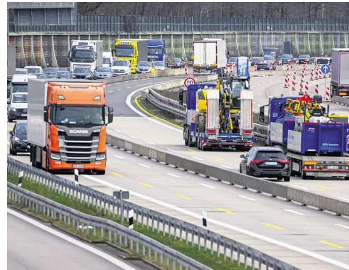
Eine Baustelle ist auf der Autobahn 4 nahe dem Kreuz Chemnitz eingerichtet. Foto: Hendrik Schmidt
