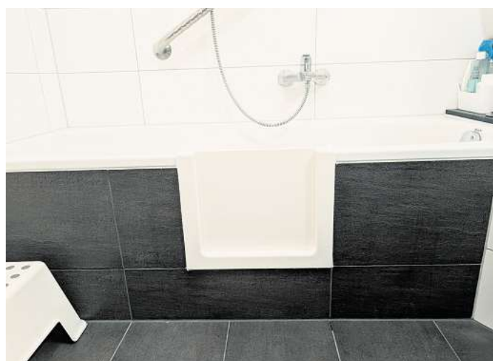
NUR EINEN TAG benötigen die BADbarrierefrei Profis, um aus einer alten Badewanne mit hohem Einstieg eine leicht begehbare Dusche zu machen oder eine Tür in die vorhanden Badewanne einzubauen.
