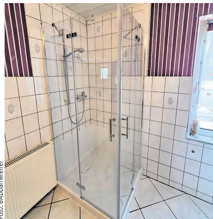
An nur einem Arbeitstag entsteht aus der alten hohen Dusche eine neue Dusche mit flachem Einstieg. Die alte Wanne wird inklusive der Verkleidung sauber entfernt und durch eine neue Dusche ersetzt.
