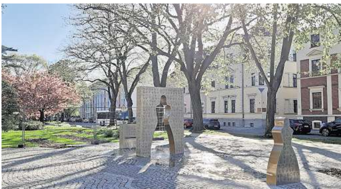
Aufgrund bestehender Mängel sowie noch nicht abgeschlossener Restarbeiten an der Anlage ist der Nymphenbrunnen am Dr.-Külz-Ring nicht in Betrieb. Foto: Stadt Eilenburg
