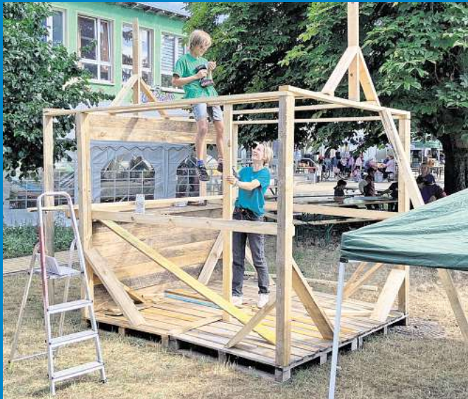
Oskar verschraubt unter den Augen der Betreuerin die Bretter des Verkaufsstandes der Kreativ-Kids – aus Paletten entsteht Schritt für Schritt ein stabiler Verkaufsplatz.
