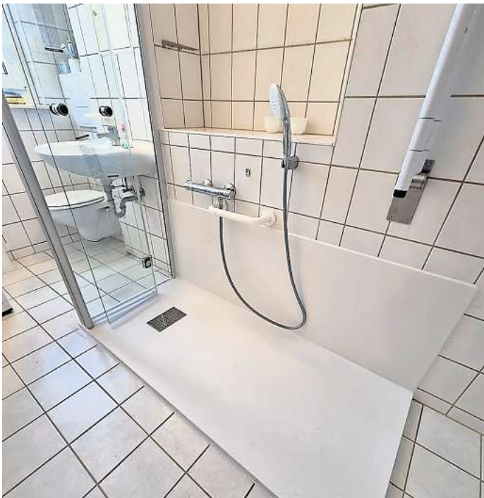
Für ein wieder selbstbestimmtes Leben in den eigenen vier Wänden: BADbarrierefrei zaubert in nur acht Stunden eine Barriere reduzierte Dusche aus der alten Badewanne. Foto: BADbarrierefrei
