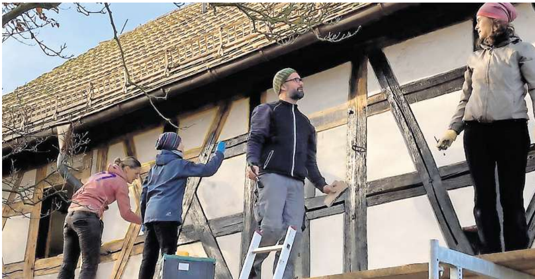
Stück für Stück saniert ein kleiner Verein jahrelang dieses historische Haus in Prießnitz. Hier wird das Fachwerk gestrichen. Foto: Verein Bauernrathaus Prießnitz
