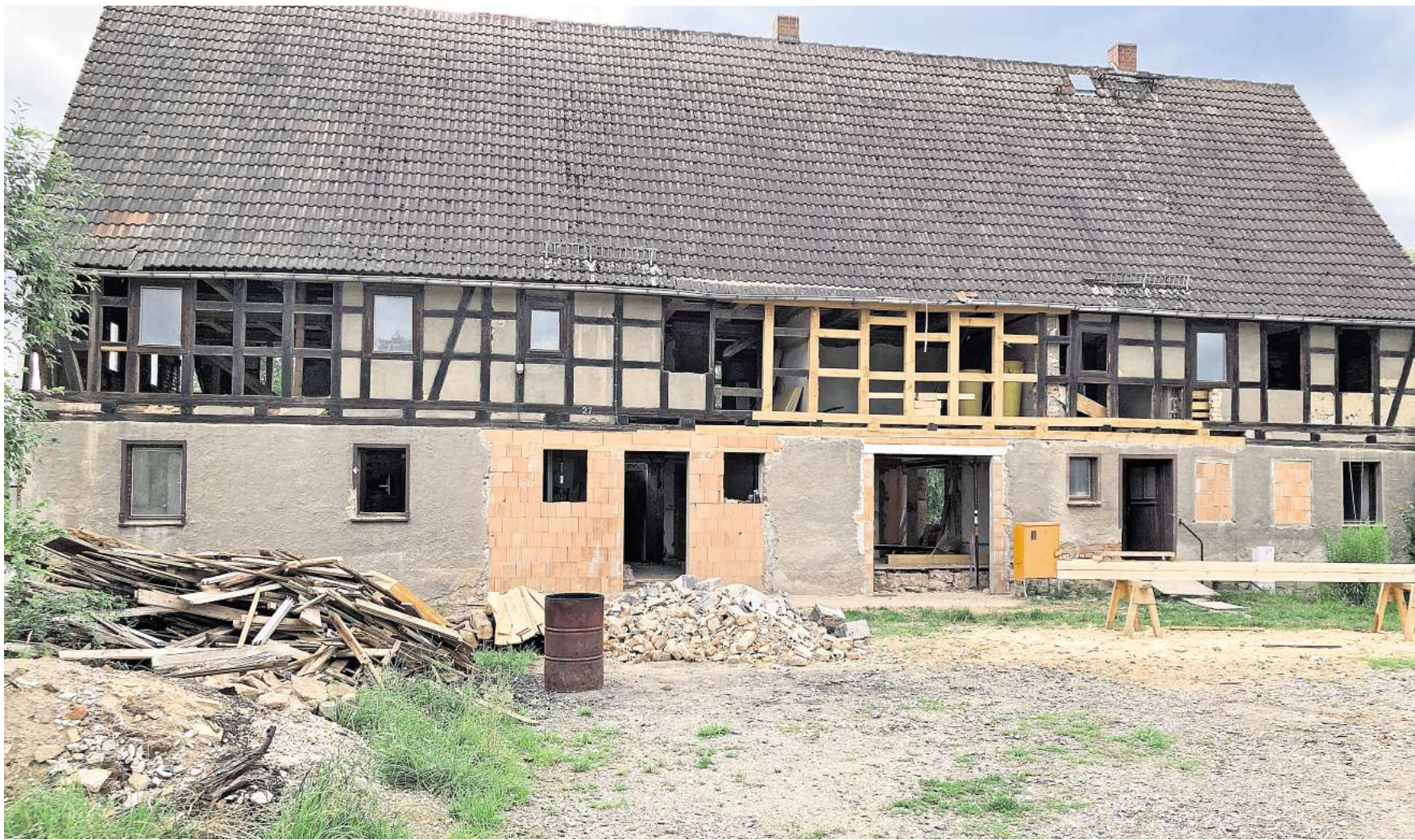
Die Sanierung hat begonnen: Das Dach ist noch alt, aber die Fachwerk-Front bereits in Ordnung gebracht, die Erdgeschosszone neu gegliedert.
