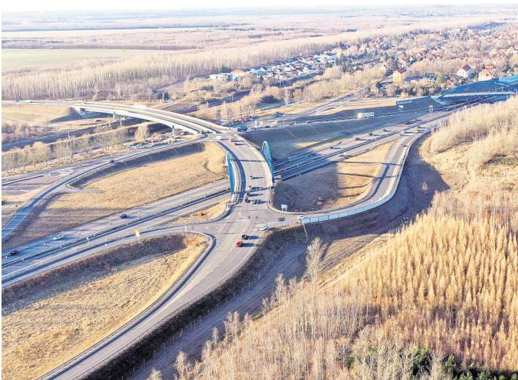
Auto- und Lkw-Fahrer können seit gestern die Anschlussstelle Zwenkau der A72 wieder nutzen.
