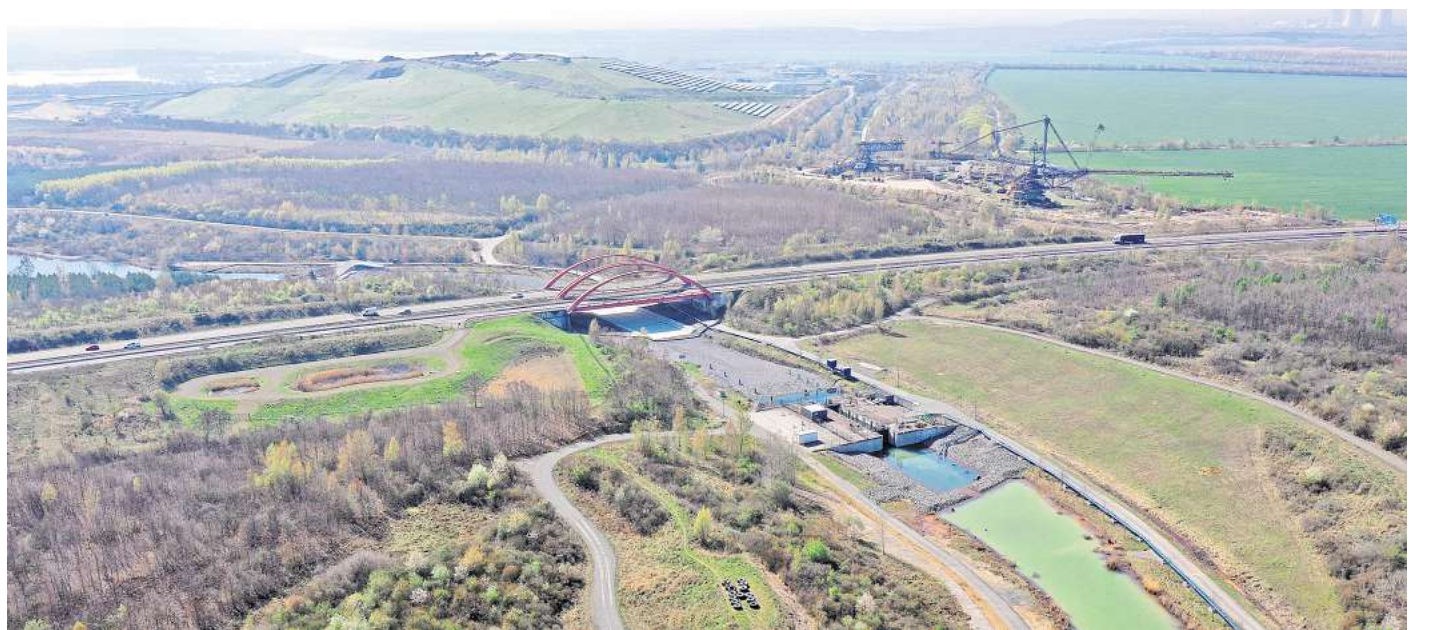
Die Schleuse zwischen Markkleeberger See und Störmtaler See.
