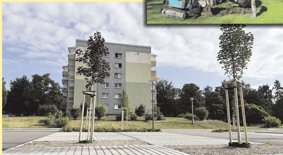
Der neue Parkplatz in Nord: Das Oberflächenwasser wird gezielt zu den Pflanzflächen geleitet.
