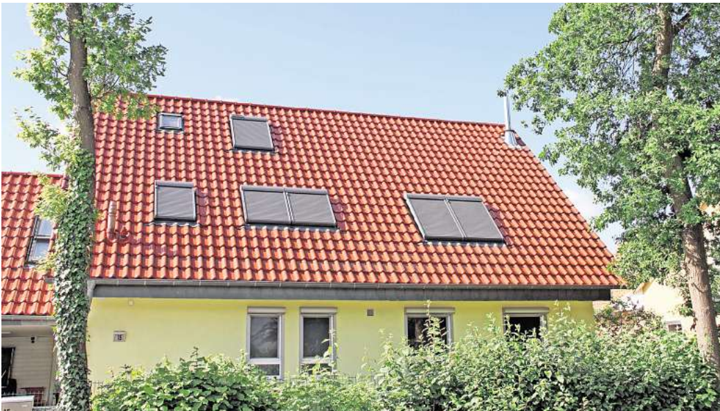
EIN GUT GEDÄMMTES DACH und außen liegender Sonnenschutz an den Dachfenstern sind der beste Schutz vor steigenden sommerlichen Spitzentemperaturen. Foto: DJD/puren/Getty Images/maho
