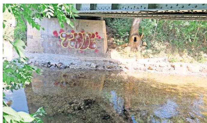
Die fertiggestellte Otterberme an der Pleißebrücke in Zschechwitz. Foto: PM
