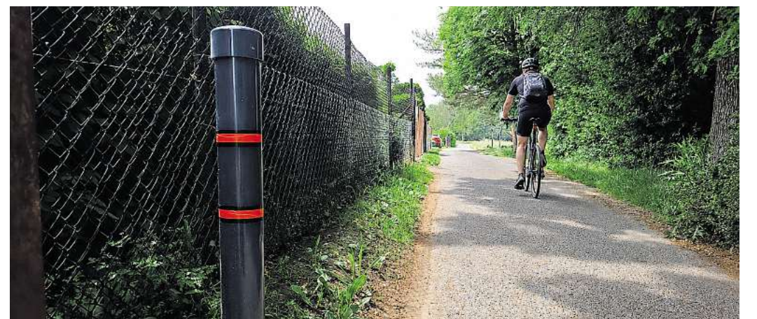
Mit der neuen Fahrradzählstelle soll die Nutzung des Radweges in Richtung Schloßig noch besser sichtbar gemacht werden. Foto: PM
