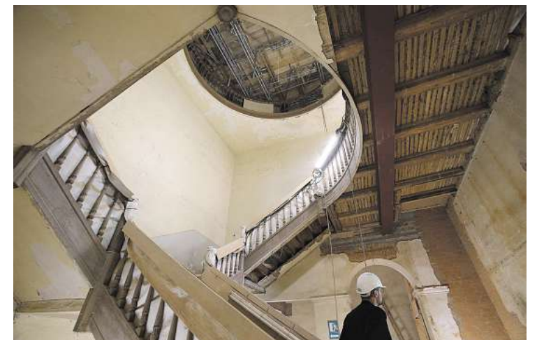
Das historische Treppenhaus.
