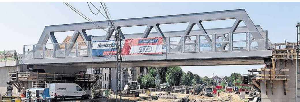
In Betrieb genommen wurde dieser Tage die neue Bahnbrücke in Sellerhausen.
