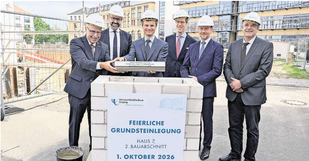
Er ist gelegt, der Grundstein für den Neubau am Universitätsklinikum Leipzig. Foto: Rico Thumser/UKL
