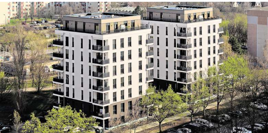
Dass die Fassaden und ein Großteil der beiden Neubauten aus Holz bestehen, ist den nun fertigen „Lipsia-Zwillingen“ im Vorbeigehen kaum anzusehen. Foto: WG Lipsia
