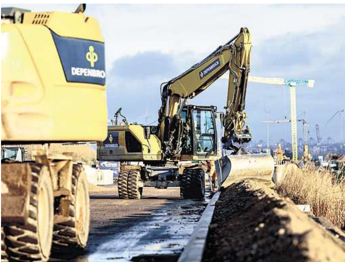
Verkehrswege zu schaffen und zu erhalten, ist ein wichtiger Job mit langfristig guter Perspektive. Foto: Depenbrock/akz-o
