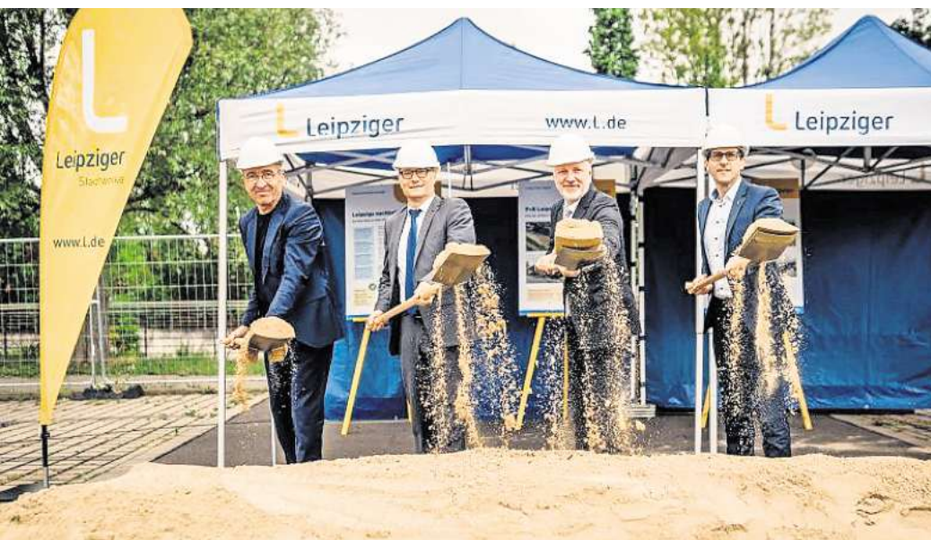
Der erste Spatenstich für eine große PV-Carport-Anlage erfolgte dieser Tage an der Neuen Messe - mit dabei sind Thomas Dienberg, Heiko Rosenthal, Sebastian Scheel und Dr. Maik Piehler (v.l.).
