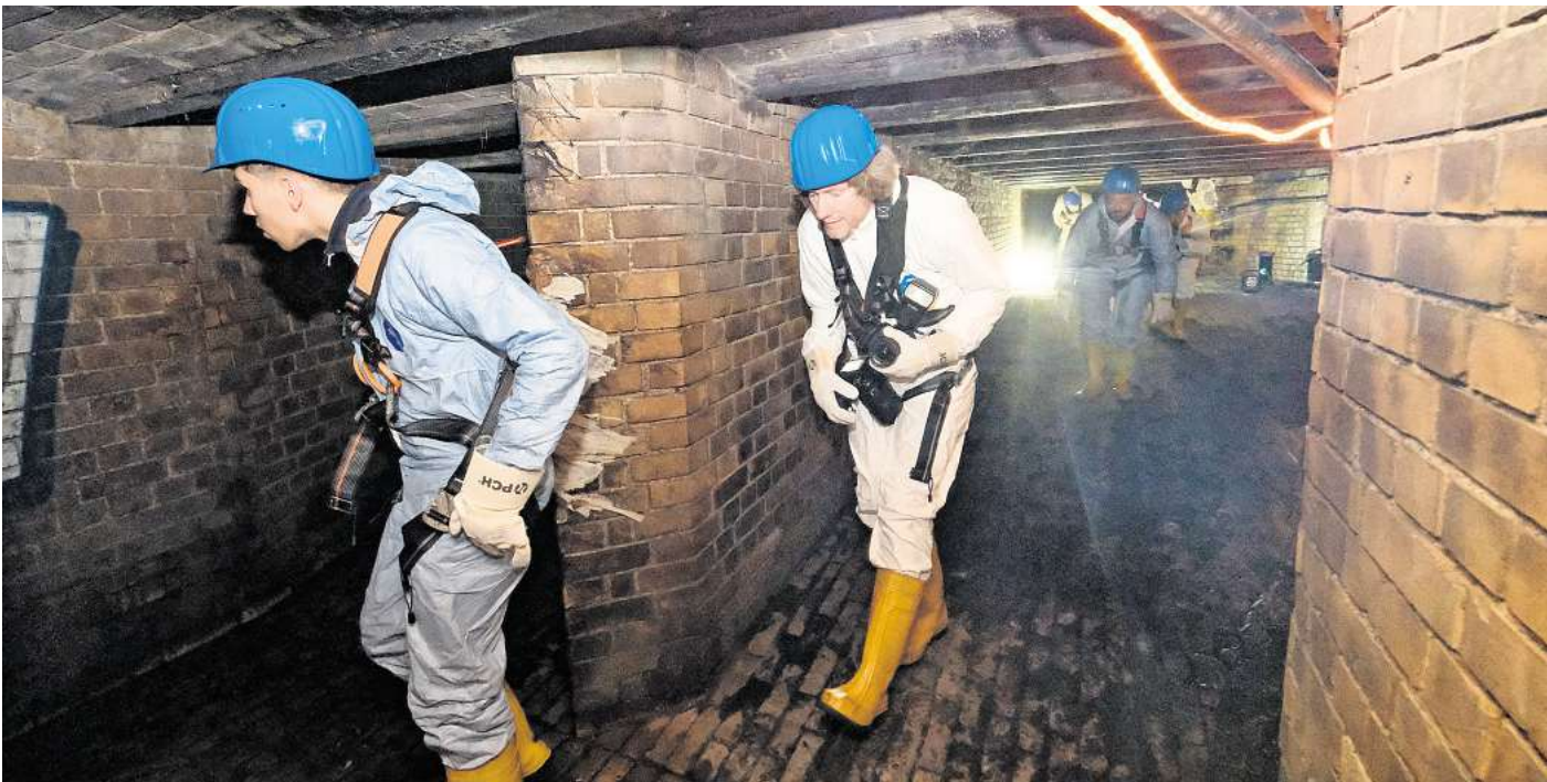
Immer schön den Kopf einziehen, denn im Leipziger Untergrund sind die Decken manchmal ganz schön niedrig: Deshalb reichte man bei der Tour durch die Kanalisation selbstverständlich Helme und Schutzausrüstungen. Fotos: Wolfgang Sens
