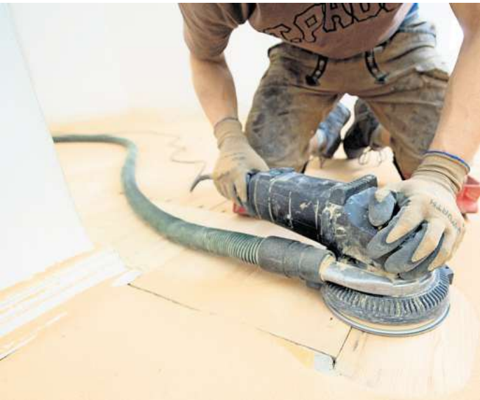
Bei DIY-Projekten gilt: Immer konzentriert und mit vollständiger Schutzausrüstung arbeiten – denn Unfälle können selbst erfahrenen Heimwerkern passieren. Foto: Inga Kjer/dpa
