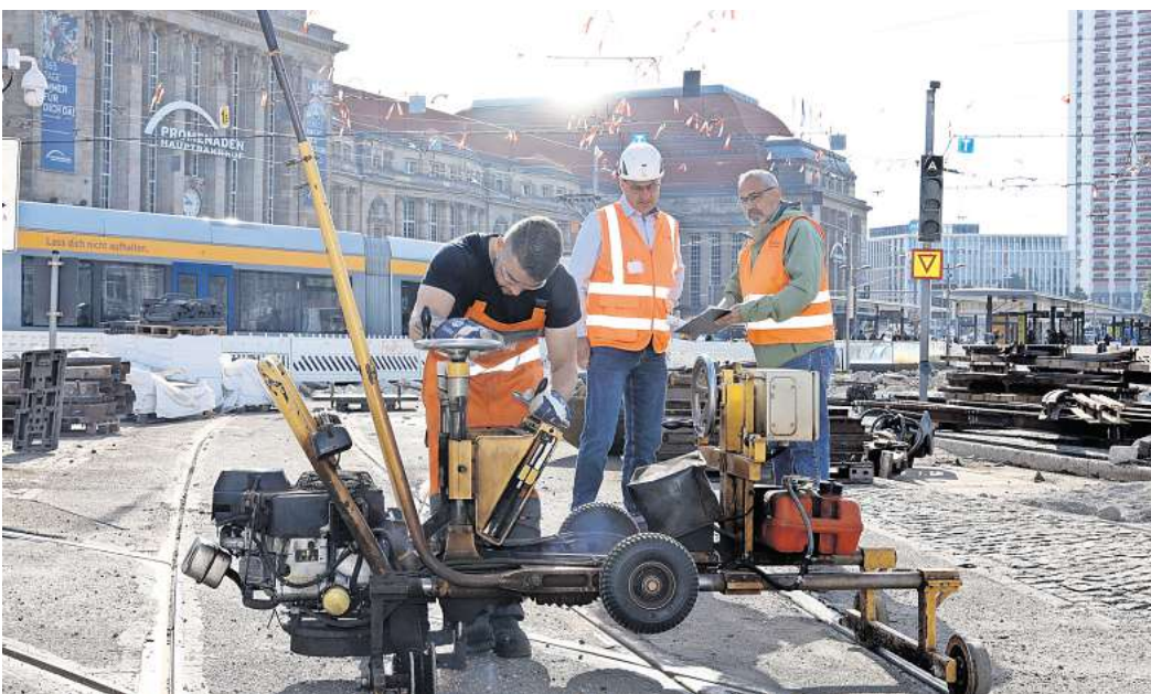
Vor dem Leipziger Hauptbahnhof wird in diesen Tagen kräftig gearbeitet: Die Gleisbauarbeiten sind nunmehr in die zweite Bauphase eingetreten. Foto: André Kempner
