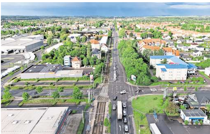
Die Otto-Schmidt-Straße/ Gießereistraße in Taucha wird ab 6. Juli für den Verkehr gesperrt. Foto: Wolfgang Sens
