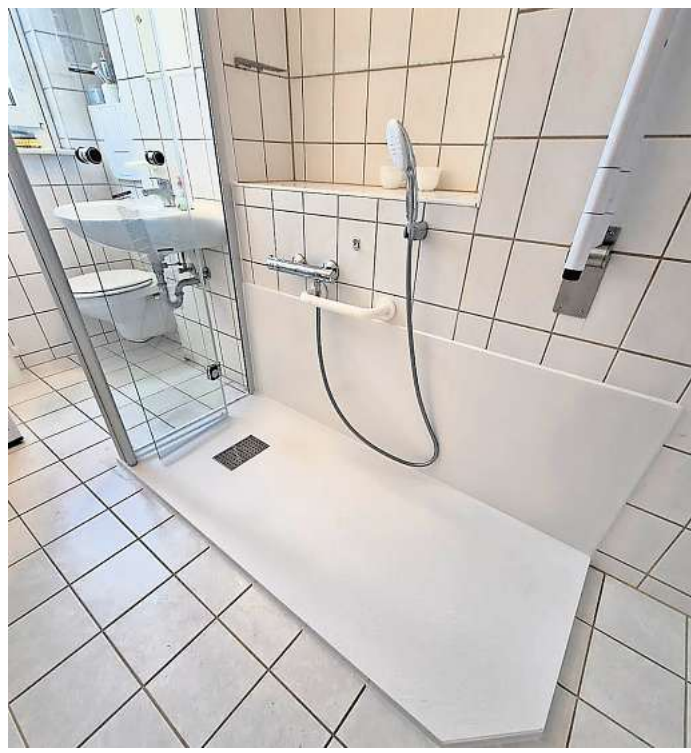
FÜR EIN WIEDER SELBSTBESTIMMTES LEBEN in den eigenen vier Wänden: BADbarrierefrei zaubert in nur acht Stunden eine Barriere reduzierte Dusche aus der alten Badewanne. Foto: BADbarrierefrei
