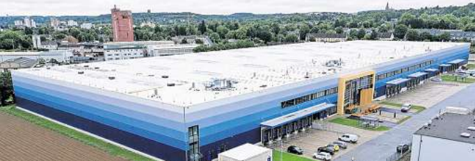
Das neue Ersatzteillogistikzentrum von Renault Deutschland. Foto: we/WMD
