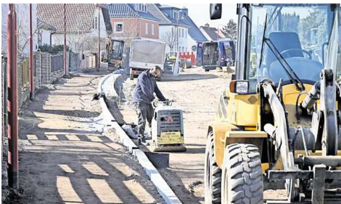
Die Goethestraße in Grimma-West war eine seit Jahren sanierungsbedürftige Straße. So sahen die Bauarbeiten im Vorjahr aus. Foto: Thomas Kube
