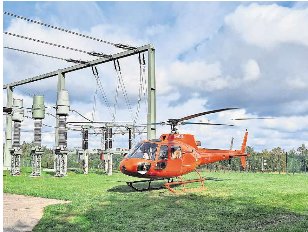
Mitnetz Strom hat in den vergangenen Wochen per Hubschrauber die Hochspannungsfreileitungen in der Region kontrolliert. Foto: Mitnetz Strom
