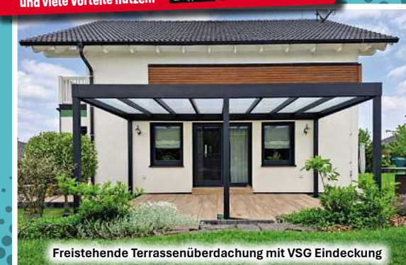
Freistehende Terrassenüberdachung mit VSG Eindeckung
