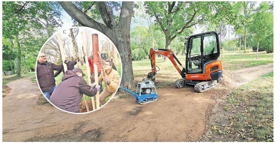
Im neuen Döbelner Park der vier Jahreszeiten werden derzeit die Wege neu angelegt und im November weitere Bäume gepflanzt. Foto: Sven Bartsch
