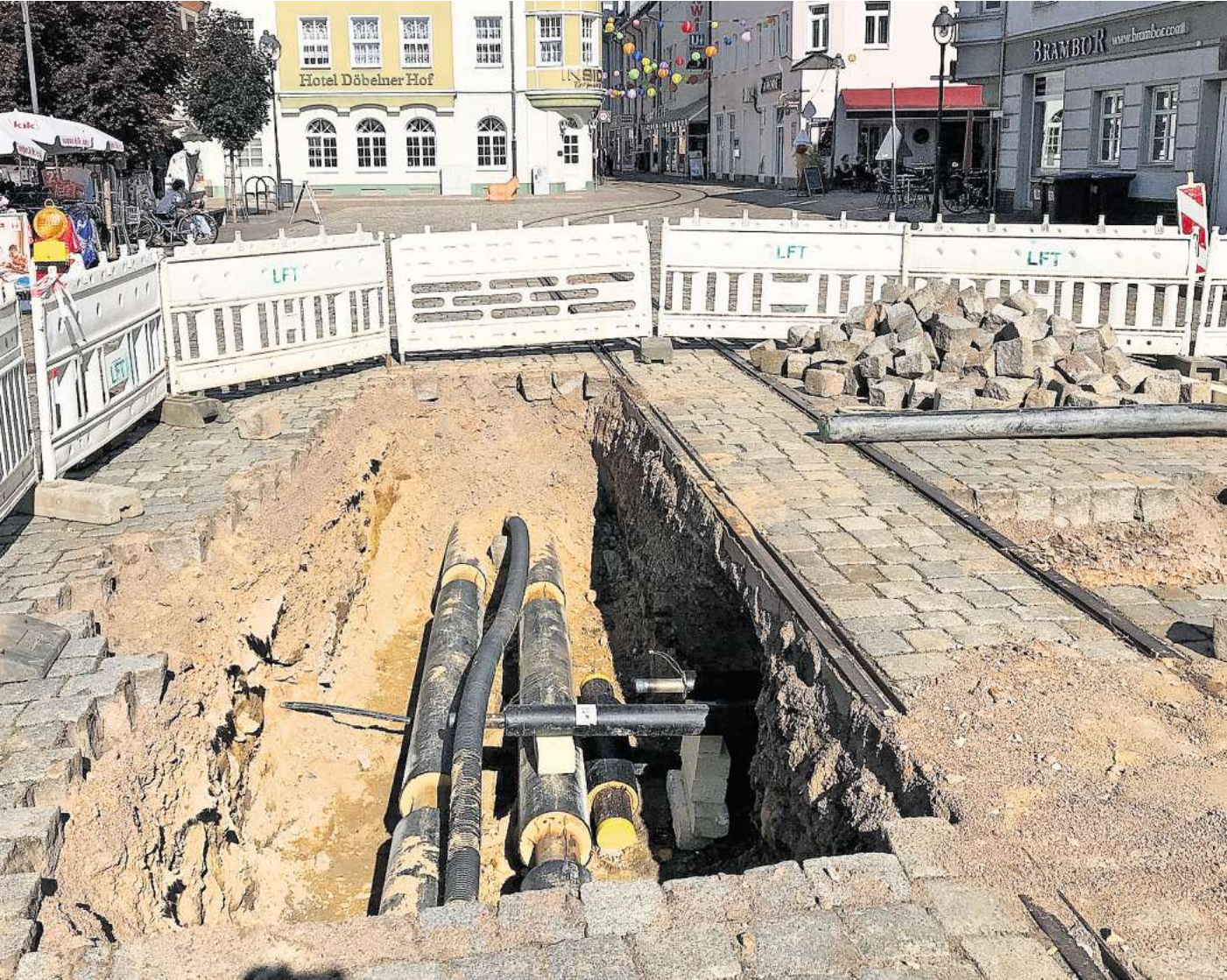
An mehreren Stellen in der Innenstadt lassen die Stadtwerke Döbeln derzeit buddeln, wie hier auf dem Niedermarkt. Foto: Olaf Büchel
