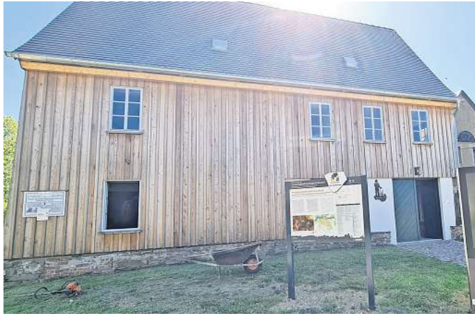
Das Gersdorfer Huthaus des Vereins Segen Gottes ErbStolln ist fertig saniert. Foto: Sven Bartsch
