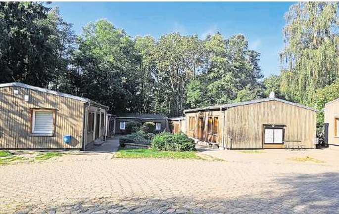
Das Reibitzer Schullandheim hat ein benötigtes Investitionsvolumen von rund 2,5 Millionen Euro. Dazu gehören auch die Übernachtungsbungalows, wo es noch nicht einmal Toiletten gibt.
