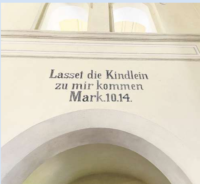
Bei der Sanierung der Kirche wurden alte Bibelverse wieder freigelegt – wie hier der Spruch ‚Lasset die Kindlein zu mir kommen‘ aus Markus 10,14 über einem Durchgang.
