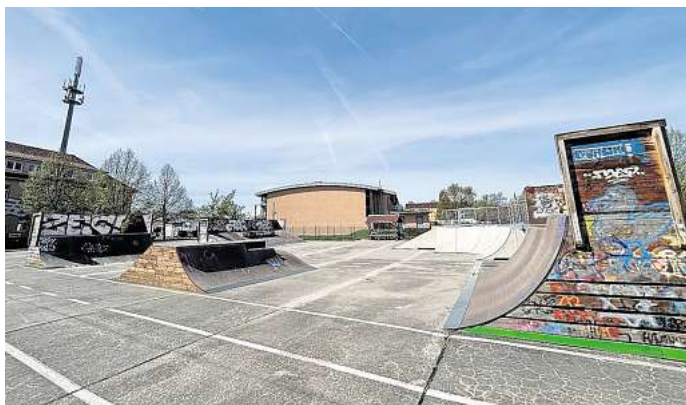
Skateranlage in der Dr.-Belian-Straße wurde umfassend erneuert. Foto: Stadt Eilenburg
