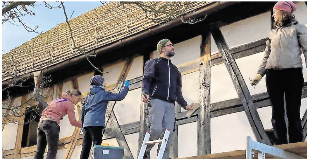
Stück für Stück saniert ein kleiner Verein jahrelang dieses historische Haus in Prießnitz. Hier wird das Fachwerk gestrichen.
