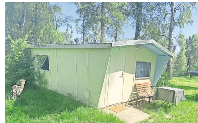
Die alten DDR-Bungalows wurden saniert und werden heute wieder vermietet.
