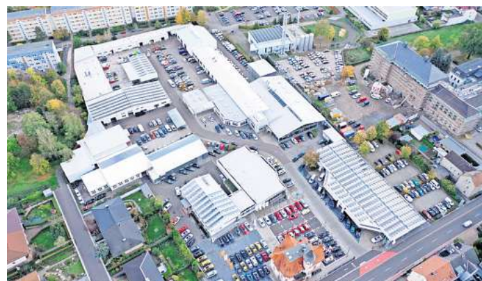
Blick von oben auf das Firmengelände von AMB in Borna. Foto: PM
