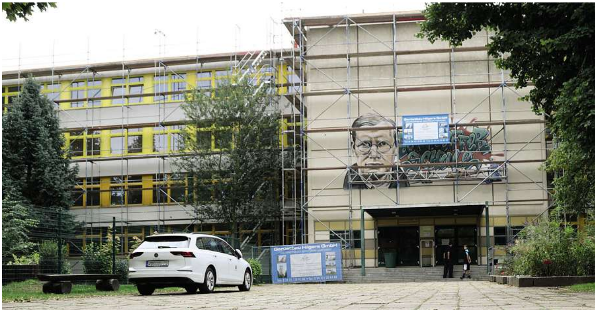
Die Bonhoeffer-Schule ist aktuell ein Investitionsschwerpunkt.
